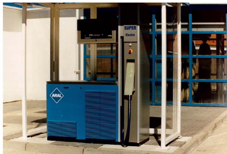
Abbildung 4, Schnellladesäule 60 kW im Rügen Projekt
